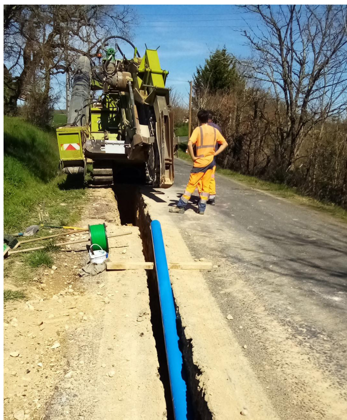
Cambon : reprise de l'adduction Croix-Rouge
